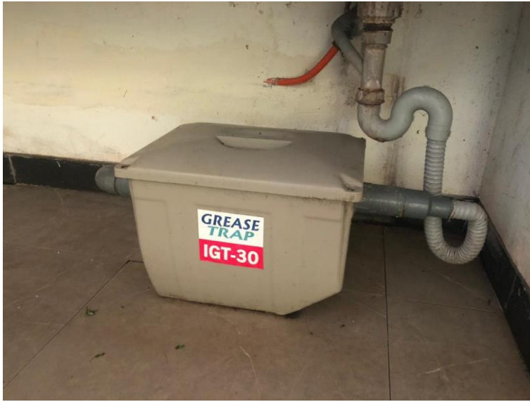
(Saluran pembuangan limbah dapur dilengkapi dengan grease trap)
