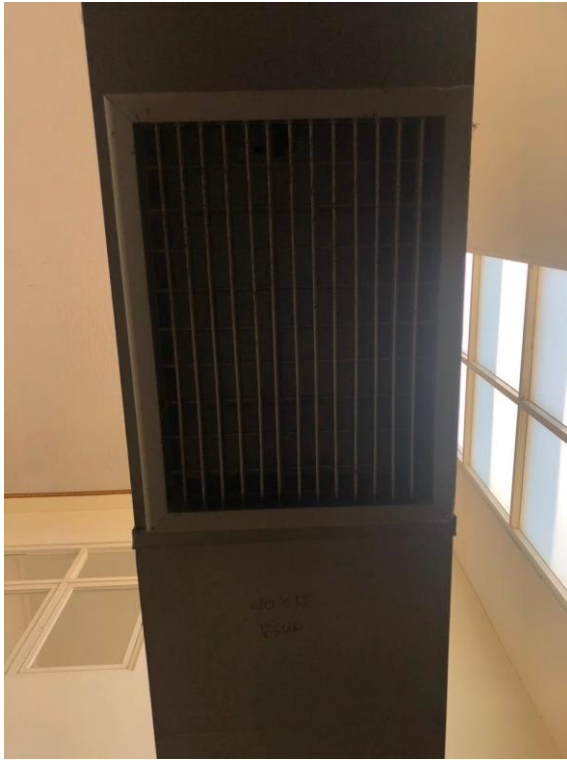
(Pengeluaran asap dapur dilengkapi dengan alat pembuangan asap)
