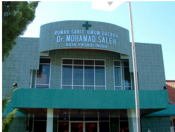
Gambar 4.1 Gedung UOBK RSUD Dokter Mohamad Saleh Kota Probolinggo
