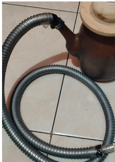
Gambar 4 Pasang selang alumunium sebagai pelindung
